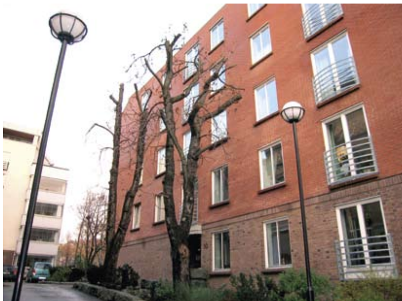
HESTEKASTANJER VED DEN GAMLE HANDELSKOLEN I SANDEFJORD. Det er viktig å sørge for at de trærne som blir tatt vare på i byggeområder får nok plass både over og under bakken, også etter at bygget er ferdigstilt, slik at slike situasjoner kan unngås.
